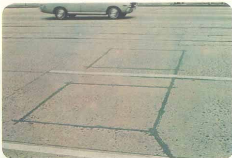
FIG. 12 — DETALHE DE UM DETECTOR DE VEÍCULOS POR LAÇO INDUTIVO INSTALADO EM TÓQUIO.
