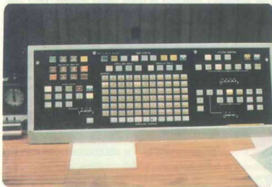
FIG. 23 — DETALHE DO "CONSOLE" DE CONTROLE DE TRÁFEGO, WASHINGTON.
